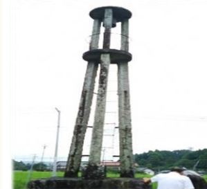
【石柱の火の見櫓】
